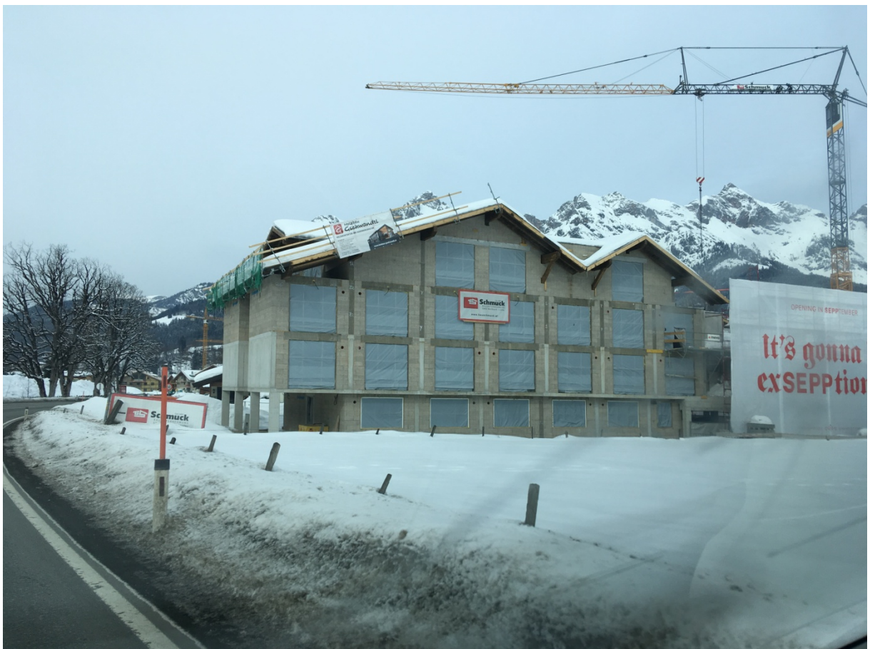
bestehende Bebauung "Hotel Josef" im Planungsgebiet
