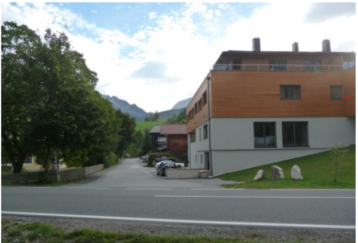
Zufahrt zum Planungsgebiet von Norden mit Erschließungsstraße und Gemeindestraße "Urchen" im Vordergrund
